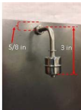
Figure 5b Vue de l'intérieur du réservoir
